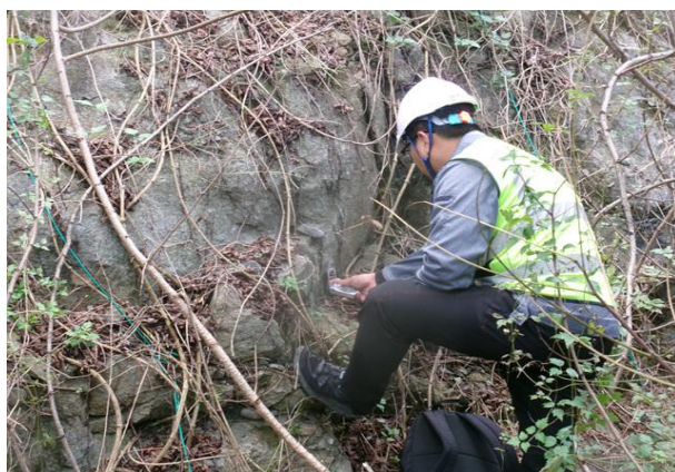
절리면 경사/경사방향 측정
