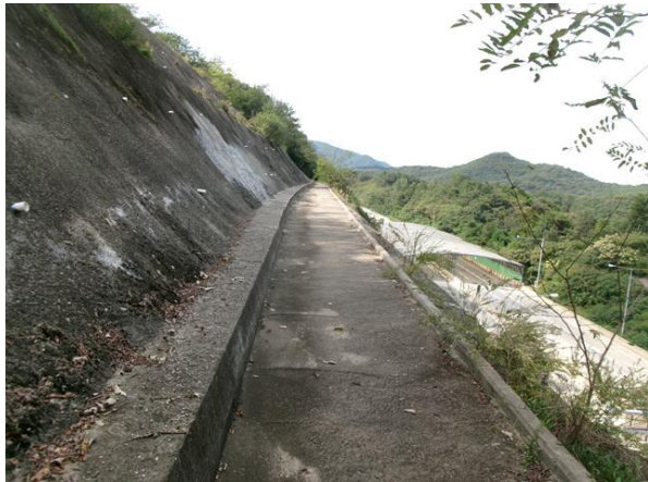
1소단 배수로 전경
